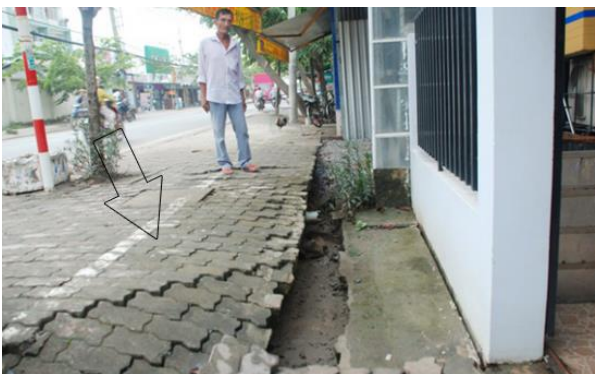
Hình 2. Vỉa hè và nền nhà bị nứt sâu - ảnh trích từ Báo Thanh niên. 1
